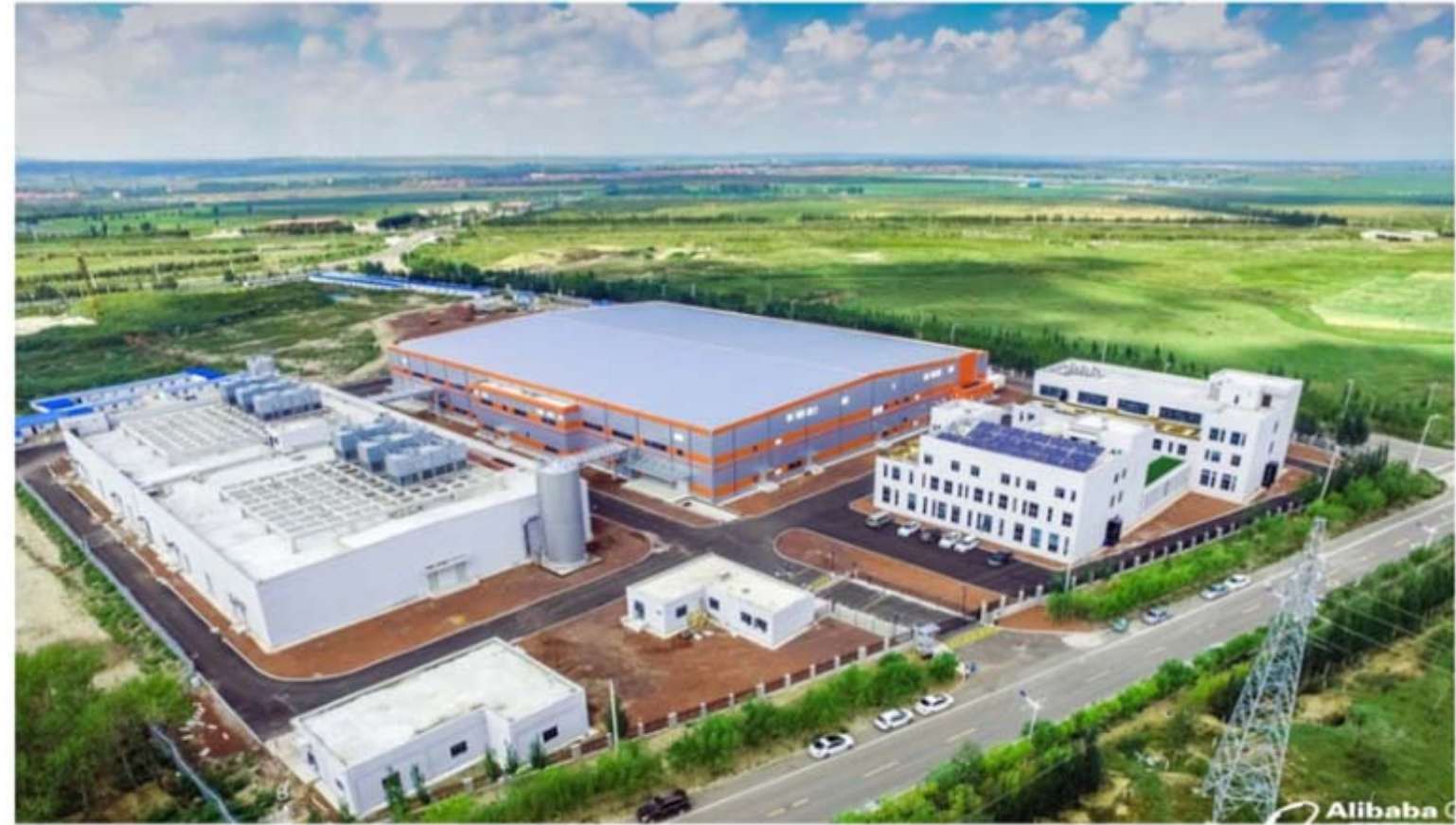
绿色数据中心： 互联网行业全球首个浸没液冷服务器集群，PUE逼近理论极限值1.0
